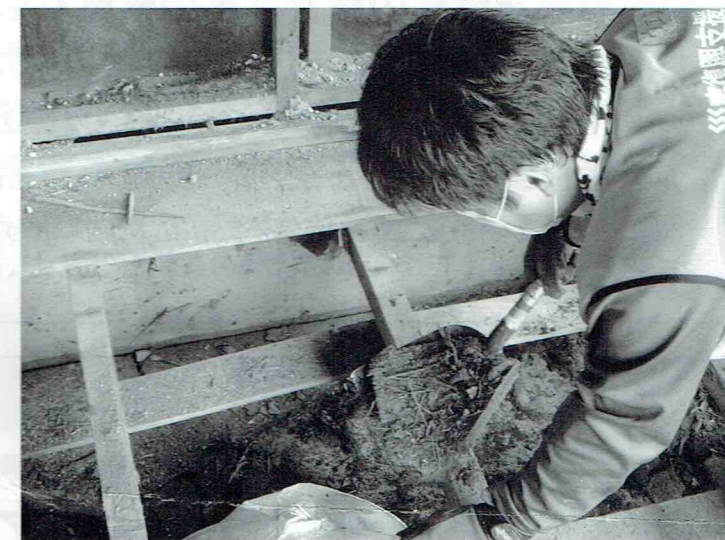
津波を被った住宅の土を土のうに詰めています。
